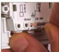
Glissez les fils dans les bornes de connexion rapide.
