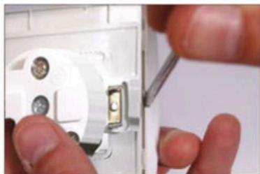
Otez la plaque avant à l'aide d'un tournevis (un tournevis plat est recommandé mais un tournevis cruciforme peut convenir).
