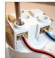
Revisssez les vis des bornes jusqu'à ce que les fils soient bloqués.
