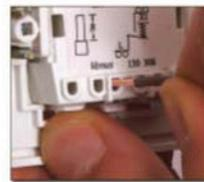
Glissez les fils dans les bornes de connexion rapide.
