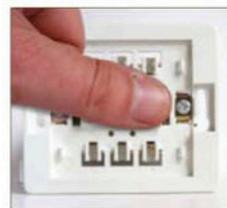
Placez l'interrupteur dans la boîte d'encastrement et maintenez-le bloqué contre le mur.
